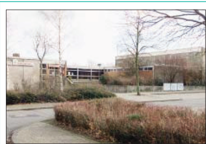
Nordsteimke: Der Ortsrat fordert die Sanierung der Sporthalle.
